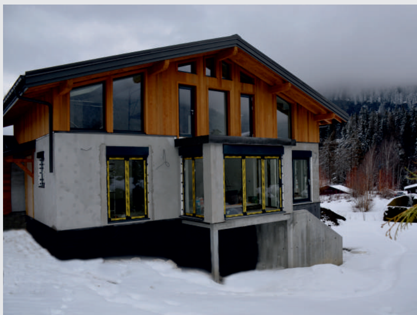
Maison Casa House Adam
