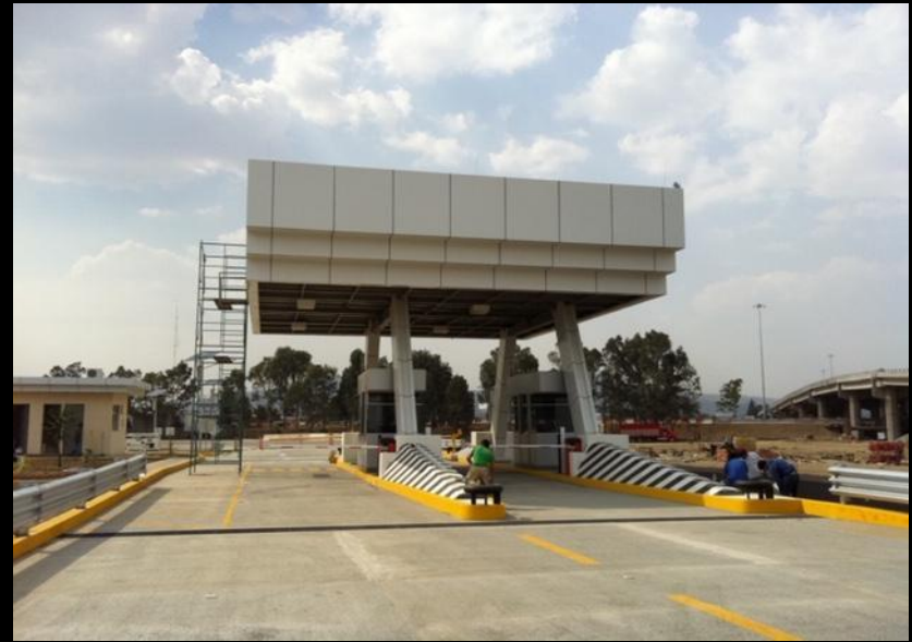
Caseta de Cobro, Circuito Exterior Mexiquense
